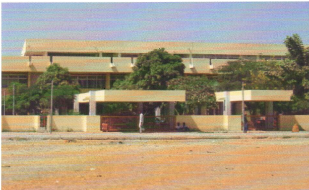
Renovation of High Court (KANO)
