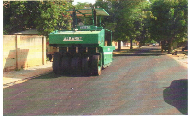
Rehab. of Durbin Katsina Road (KANO)
