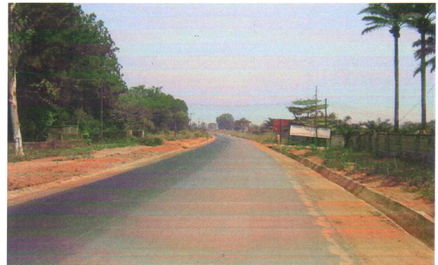
Rehab. of Ama-Hausa-Nekede Road (IMO)
