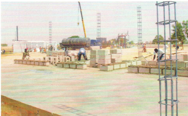
Asca Bitumen Offices (KANO)
